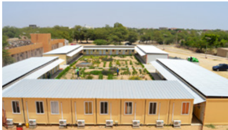
VUE PANORAMIQUE DES MODULES
