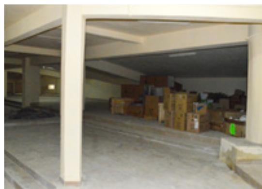
MATÉRIEL EN VOIE D'INSTALLATION
