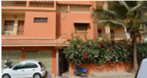
FAÇADE ANTENNE DE L'UGB
